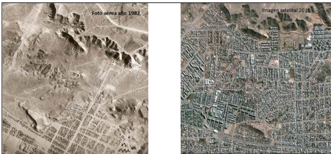
Figura 4: ambas imágenes muestran el avance de la urbanización sobre cauces y hacia sectores de fuertes pendientes considerados de peligro natural.
