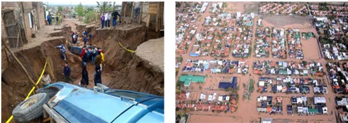
Figura 5: a) erosión encauzada y deterioro de tendido de servicios área de asentamiento irregular b) sectores inundados.
